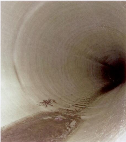
Ein nachhaltiges Sanierungsergebnis.
