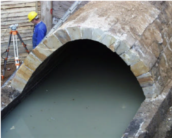
Bild 1: Sandsteinübermauerter Kanal unter dem Wiener Platz in Dresden (Foto: Lehrstuhl Stadtbauwesen)
